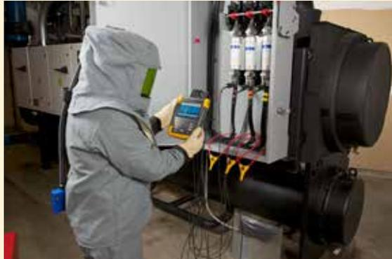
Schließen Sie einfach die Leitungen für die Spannungsmessung und die flexiblen Stromzangen an die den Motor versorgende Stromversorgung an.
