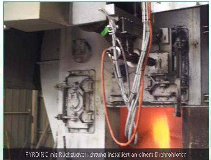
PYROINC mit Rückzugvorrichtung installiert an einem Drehrohrföfen
