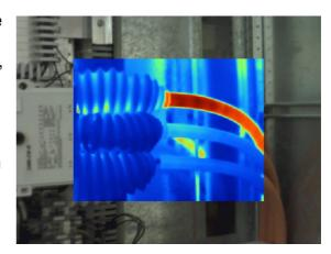
Das Risiko unplanmässiger Anlagestillstände und Beschädigungen an betriebsrelevanter Infrastrutkur werden mit der periodischen Durchführung von thermografischen Inspektionen an den relevanten Elektroanlageteilen (Produktion, Versorung, Hauptverteilung, Rechenzentren, Lagerung, Logistik etc.) nachhaltig gesenkt. Unser Motto "wir finden immer eine Auffälligkeit" hat sich in der Vergangenheit immer wieder bestätigt.
